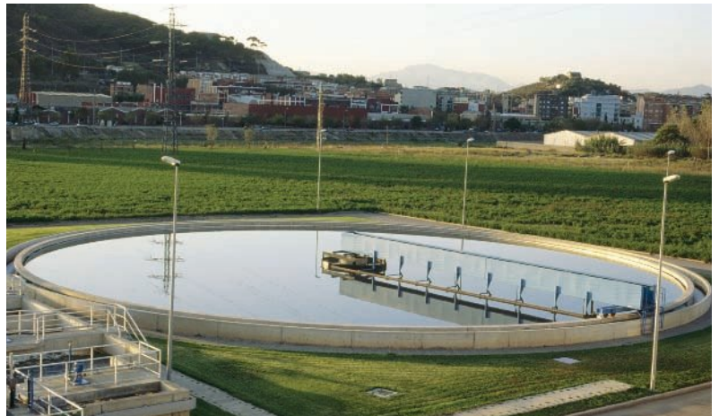
Fig. 5.6. EDAR. Estación depuradora de aguas residuales.
